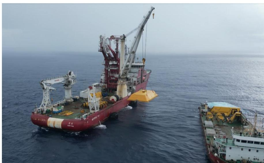
图 2-18-3 玻璃纤维 PLET 保护罩海上工程应用
